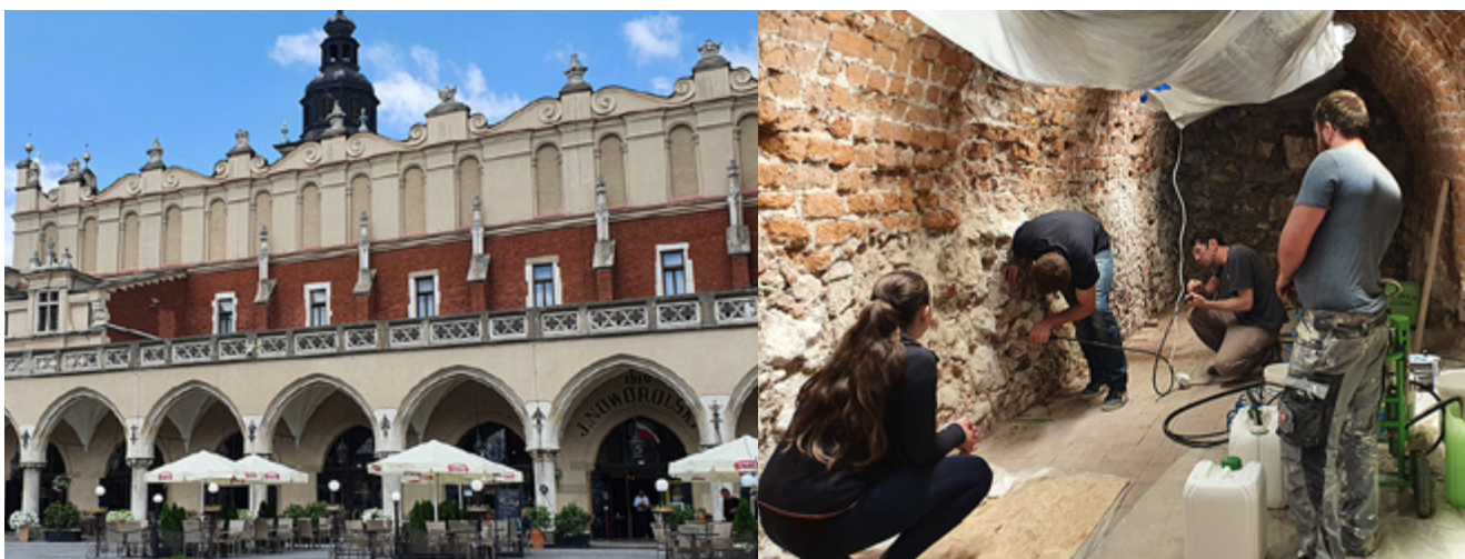
Sukiennice, Kraków – iniekcja ciśnieniowa uszczelniająca murów podziemi
