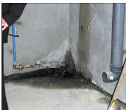
Skutki braku izolacji w piwnicy budynku mieszkalnego
