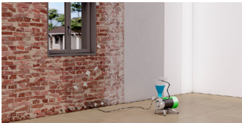
Przepona pozioma płynem iniekcyjnym KÖSTER Mautrol 2K przeciw kapilarnemu podciąganiu wilgoci metodą iniekcji niskociśnieniowej w kombinacji z renowacją mokrych lub zawilgoconych murów – wykonywane od wewnątrz pomieszczeń
