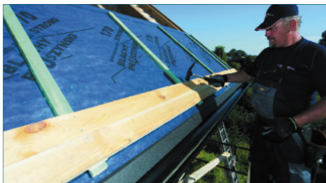
Przygotowanie konstrukcji przy okapie dachu jest szczególnie istotne w kontekście późniejszych prac dekarzskich Fot. Blachy Pruszyński
