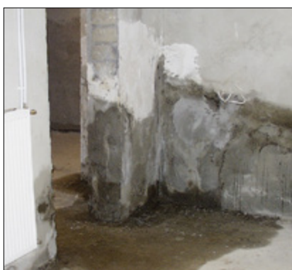
Skutki braku izolacji w piwnicy budynku mieszkalnego
