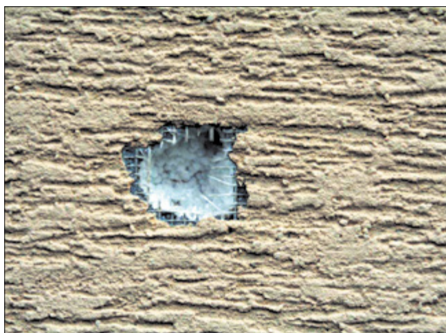
Uszkodzenie mechaniczne
