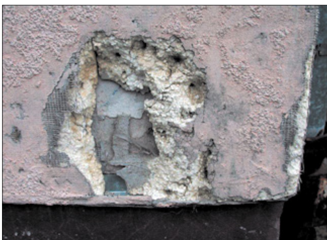
Uszkodzenie mechaniczne
