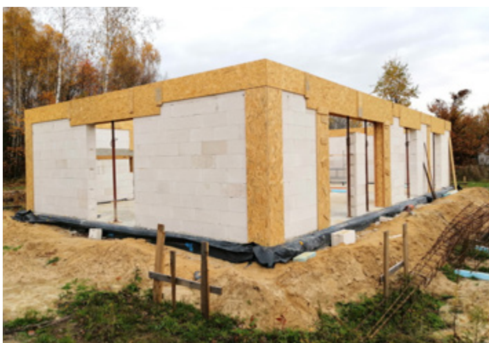
Ściany parteru budynku można nawet postawić samemu (przykład)
