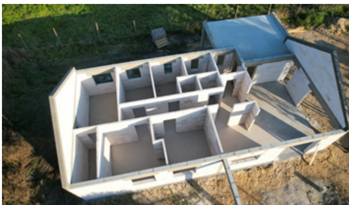
Łatwa konstrukcja to niższe koszty budowy
