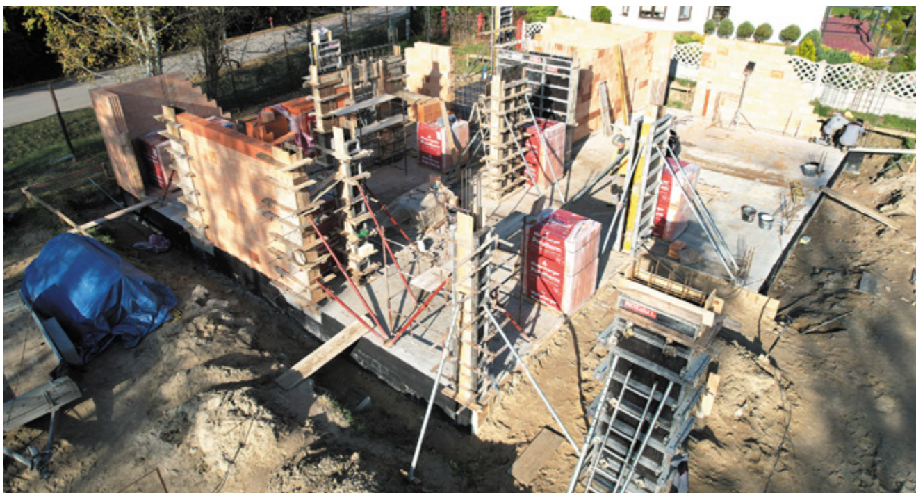
Skomplikowana budowa, dużo elementów żelbetowych to wyższe koszty budowy
