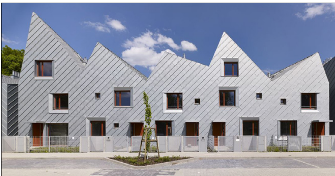
MikMak House we Wrocławiu – elewacja wykonana w technologii na rąbek kątowy z blachy cynkowo-tytanowej RHEINZINK prePATINA blaugrau. Projekt został opracowany przez projektantów z ArC2 Fabryka Projektowa
