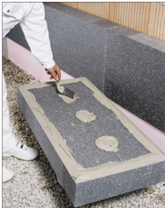
Klej nanosi się na płytę metodą punktowo-liniową
