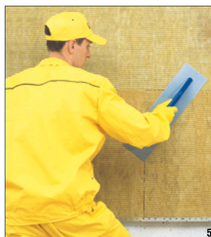
Fot. 1–5. Wybrane etapy prac przy montażu systemów ociepleń: 1 – kontrola stanu nośności podłoża, 2 – gruntowanie nasiąkłego podłoża, 3–4 – nakładanie zaprawy klejowej na płytę dociepleniową (3 – metodą punktową, 4 – pacą ząbkowaną), 5 – przyklejanie płyt izolacyjnych
