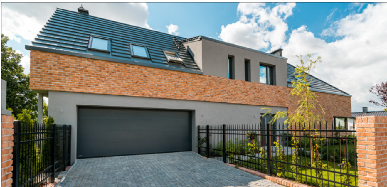
Fot. 4. Inwestorzy zdecydowali się na przełamanie prostoty budynku wyjątkowo oryginalną cegłą rozbiórkową. Element elewacji w połączeniu z płotem to idealne tło dla antracytowej stolarki
