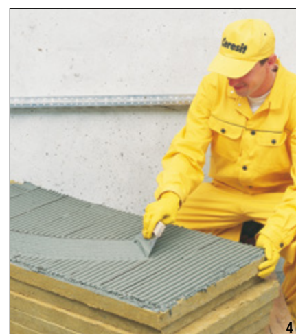
Fot. 1–5. Wybrane etapy prac przy montażu systemów ociepleń: 1 – kontrola stanu nośności podłoża, 2 – gruntowanie nasiąkłego podłoża, 3–4 – nakładanie zaprawy klejowej na płytę dociepleniową (3 – metodą punktową, 4 – pacą ząbkowaną), 5 – przyklejanie płyt izolacyjnych
