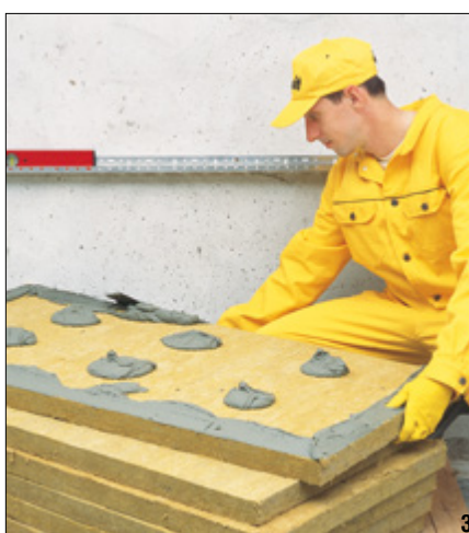
Fot. 1–5. Wybrane etapy prac przy montażu systemów ociepleń: 1 – kontrola stanu nośności podłoża, 2 – gruntowanie nasiąkłego podłoża, 3–4 – nakładanie zaprawy klejowej na płytę dociepleniową (3 – metodą punktową, 4 – pacą ząbkowaną), 5 – przyklejanie płyt izolacyjnych
