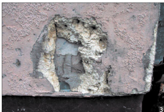
Usterki na ocieplonych elewacjach wymagające naprawy: 1 – odspojenie w warstwie zbrojonej, 2 – uszkodzenie mechaniczne spowodowane przez uderzenie twardym przedmiotem, 3 – uszkodzenie mechaniczne, 4 – Uszkodzenia spowodowane przez gradobicie Fot. archiwum SSO
