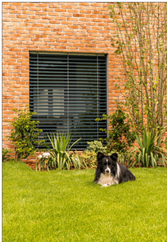
Fot. 7. Żaluzje fasadowe są bardzo funkcjonalnym rozwiązaniem – pozwalają na swobodną regulację wpadającego do wnętrza światła
