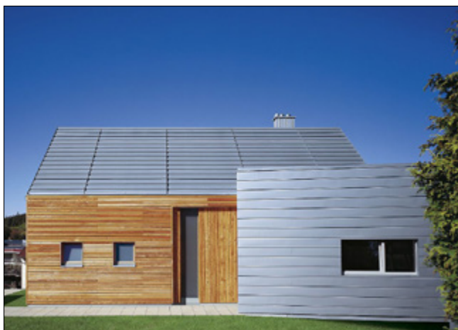
Elewacje wykonane z blachy cynkowo-tytanowej RHEINZINK prePATINA blaugrau, w technologii na rąbek stojący kątowy
