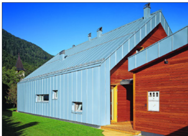
Elewacje wykonane z blachy cynkowo-tytanowej RHEINZINK prePATINA blaugrau, w technologii na rąbek stojący kątowy
