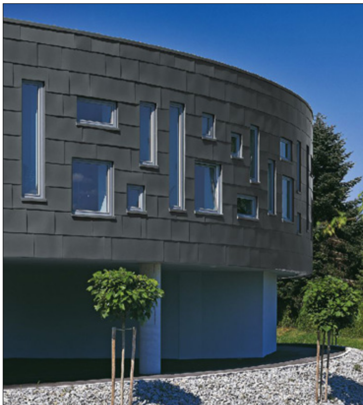
Elewacja w technologii nieregularnej łuski z grafitowej blachy RHEINZINK prePATINA schifergrau
