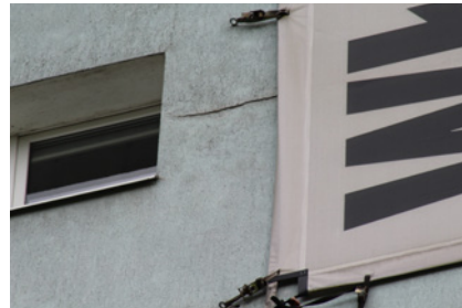
Fot. 10. Miejsce łączenia termoizolacji z EPS-u i wełny mineralnej – ten obszar zawsze musi podlegać dokładnej kontroli
