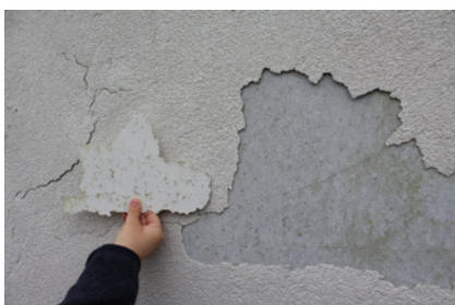
Fot. 12a, 12b. Inną wagę mają spękania samego tynku a inną spękania tynku i warstwy zbrojonej
