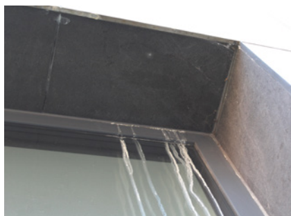
Fot. 4 – 5. Skropliny wypływające spod ościeży są bezpośrednim wskazaniem do wykonania ekspertyzy określającej przyczynę. taki zapis powinien znaleźć się w protokole pokontrolnym
