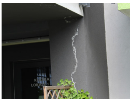
Fot. 13a, 13b. Wykwyty na powierzchni elewacji także wymagają wyjaśnienia
