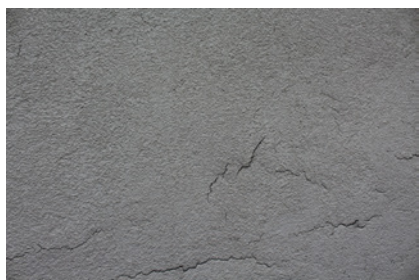
Fot. 12a, 12b. Inną wagę mają spękania samego tynku a inną spękania tynku i warstwy zbrojonej
