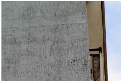
Fot. 10. Miejsce łączenia termoizolacji z EPS-u i wełny mineralnej – ten obszar zawsze musi podlegać dokładnej kontroli
