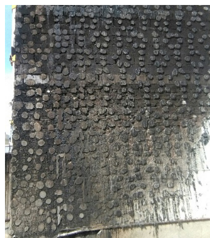
Fot. 14. Skutek klejenia styropianu tylko na placki
