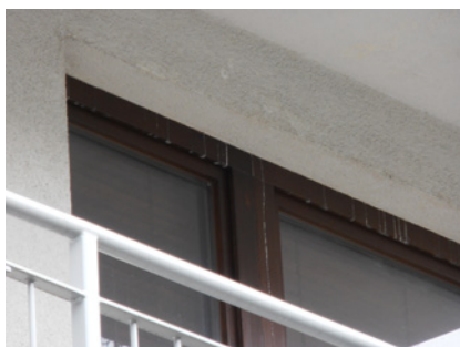
Fot. 4 – 5. Skropliny wypływające spod ościeży są bezpośrednim wskazaniem do wykonania ekspertyzy określającej przyczynę. taki zapis powinien znaleźć się w protokole pokontrolnym
