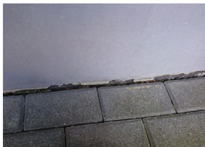
Fot. 7. Zaniedbanie odpowiedniego wykonania systemu przy gruncie jest w wielu przypadkach początkiem późniejszych problemów
