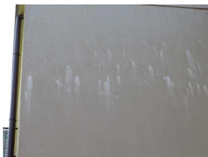
Fot. 13a, 13b. Wykwyty na powierzchni elewacji także wymagają wyjaśnienia
