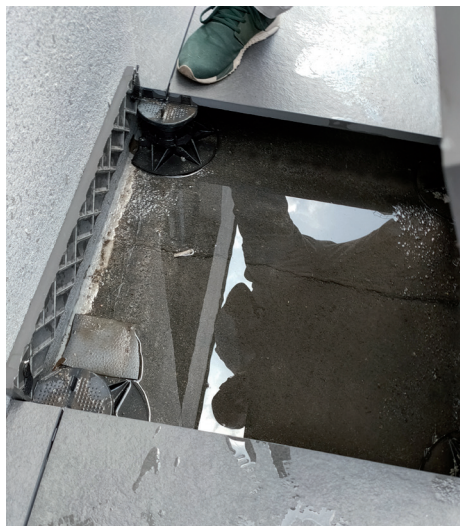
Fot. 3-4. Rezultat bezkrytycznej zamiany układu z płytkami na układ drenażowy
