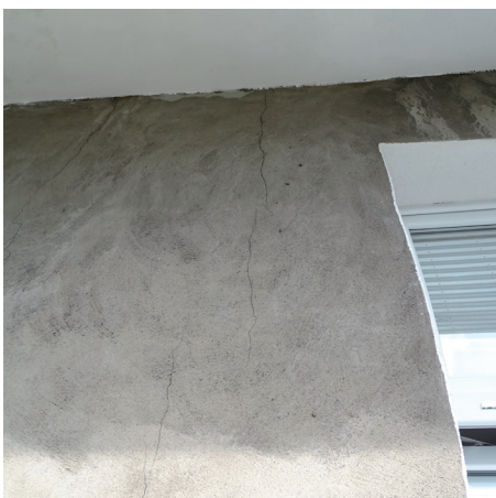
Fot. 7a, 7b. Zignorowanie stwierdzonych uszkodzeń ścian podczas diagnostyki balkonów jest niedopuszczalne
