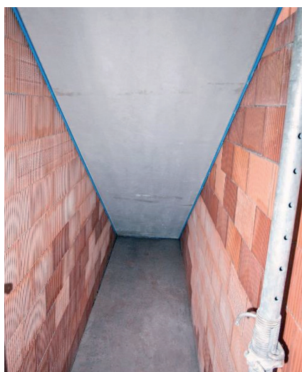
Fot. 1–2. Bieg schodowy – widok z góry [1] i z dołu [2]; widoczna ciągła niebieska linia będąca elementem izolacji akustycznej jest gwarancją właściwego zabezpieczenia dylatacji przed możliwością powstania mostków akustycznych;
