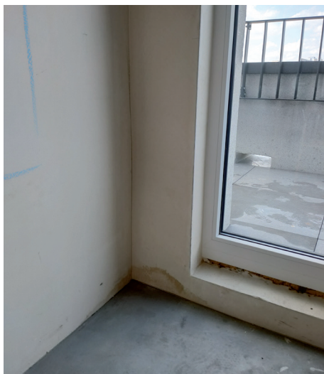
Fot. 3-4. Rezultat bezkrytycznej zamiany układu z płytkami na układ drenażowy
