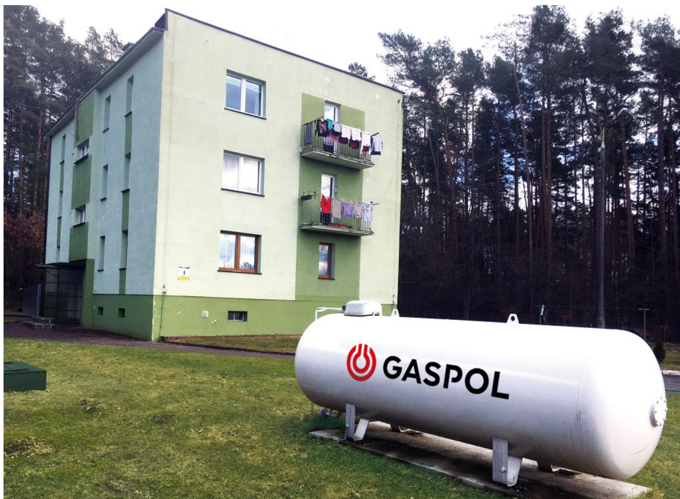
Dom wielorodzinny zasilany gazem płynnym ze zbiornika naziemnego o pojemności 6700 l
